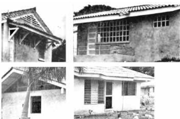
Imagen 17. Comparativa de las soluciones arquitectónicas de ventilación de las viviendas de Betania diseñadas por Rosa (arriba) y Arneson (abajo)
